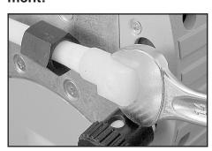
➤ Vissez avec une clé anglaise (taille 14) la douille du raccord dans le tuyau.
